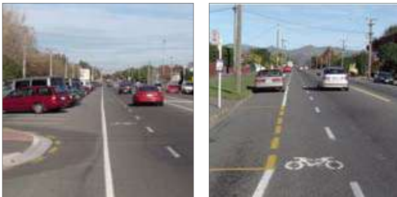
Obr. 18,19 – Cyklistické pruhy podél parkovacích pruhů, Christchurch - Nový Zéland. (Foto: Tim Hughes)
