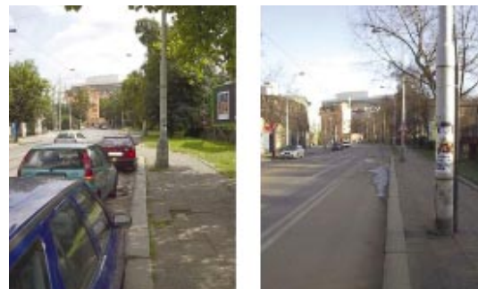
Jedním ze způsobů zajištění bezpečnosti cyklistů je budování cyklistických stezek. (Praha – porovnání stavu před budováním cyklostezky a po jejím dokončení)
